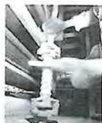
ขัดทำความสะอาด Insulation shaft Discharge electrode
