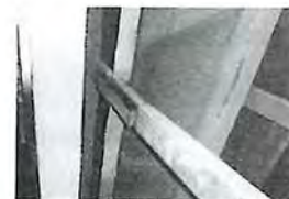
ใส่เหล็ก Flat bar.เชื่อมประทุน Frame part centre Discharge electrode แดกหลุด
