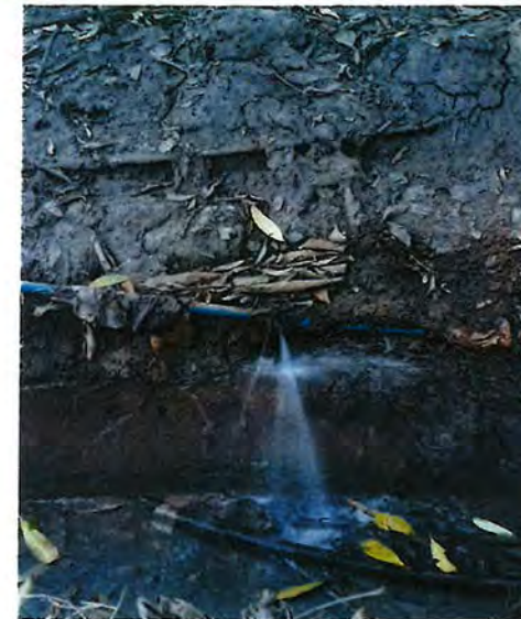
ท่อน้ำรั่วที่โรงน้ำ RAWMILL FEED
