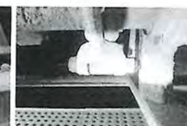
ใส่เหล็ก Flat bar.เชื่อมประทุน Frame part centre Discharge electrode แดกหลุด
