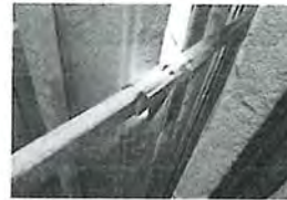
ใส่เหล็ก Flat bar.เชื่อมประทุน Frame part centre Discharge electrode แดกหลุด
