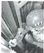
ขัดทำความสะอาด Insulation shaft Discharge electrode
