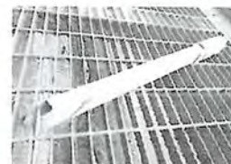
Frame part centre ทักชำรุดหลุดและแตกร้าว
