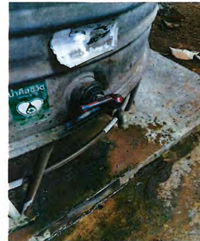
valve น้ำรั่วถังน้ำสโมสร
