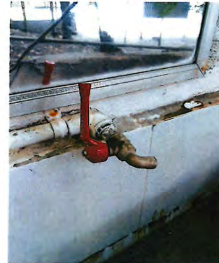
valve น้ำรั่วที่ห้องน้ำ cement
