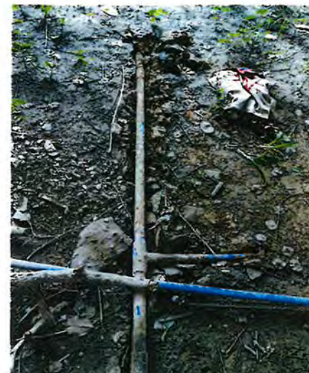
ท่อน้ำรั่วที่ Raw mill 5
